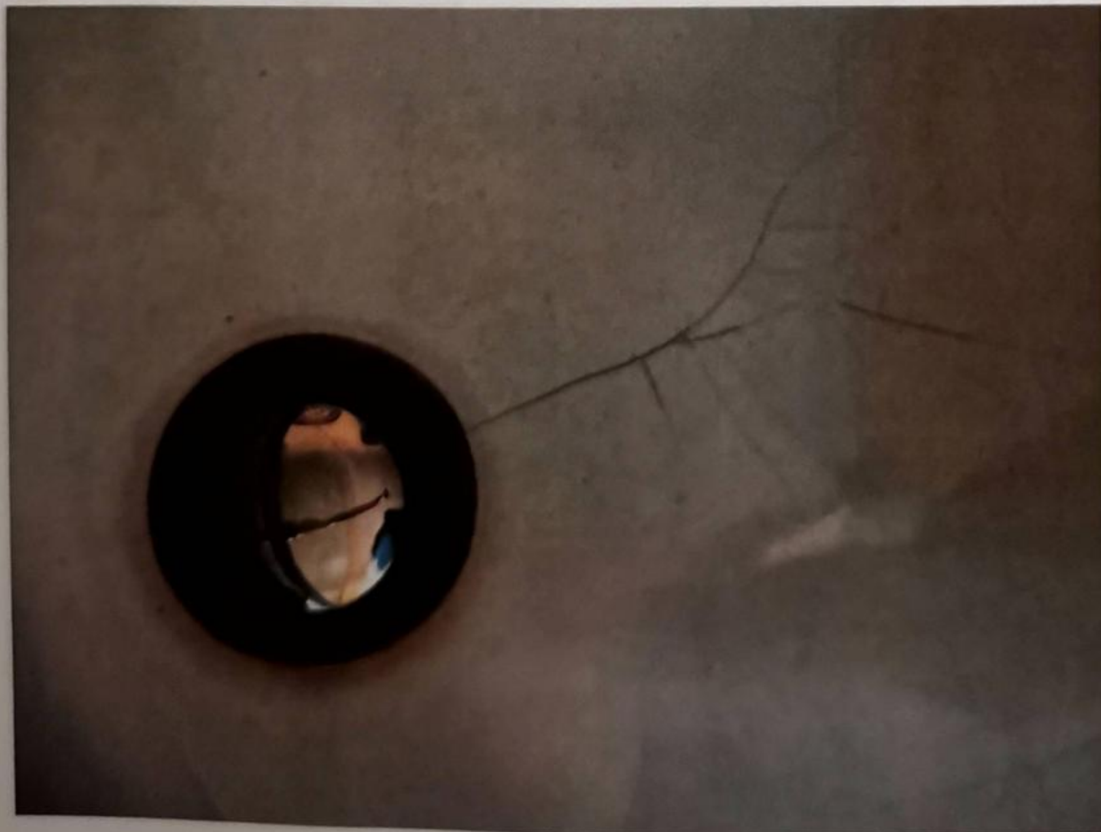
Foto 11 Particolare lavandino rotto
